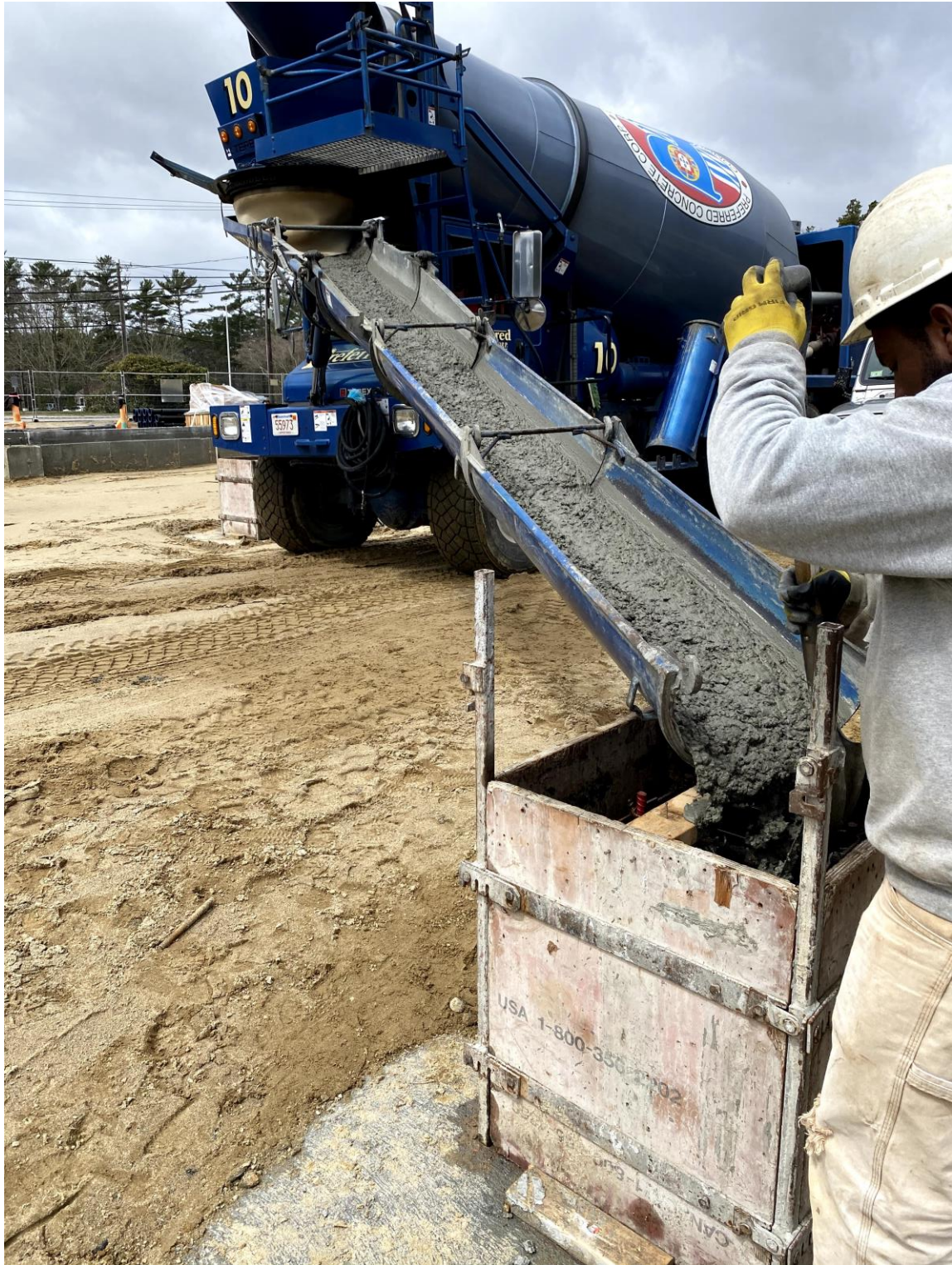
Concrete Pour at Interior Piers
